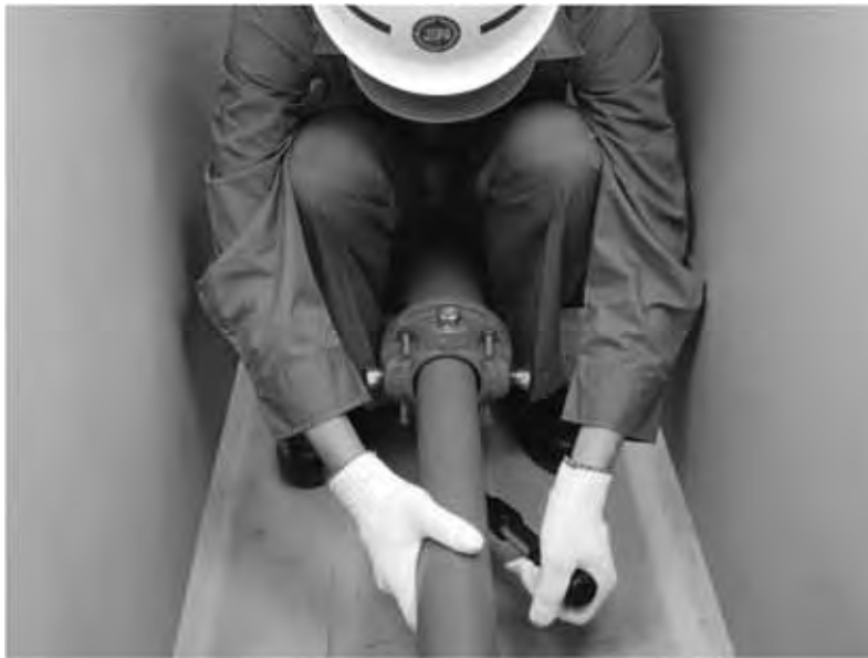
写真2 抜け止め押輪 施工性試験状況
