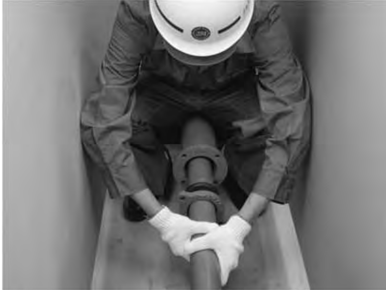
写真1 直管 施工性試験状況
